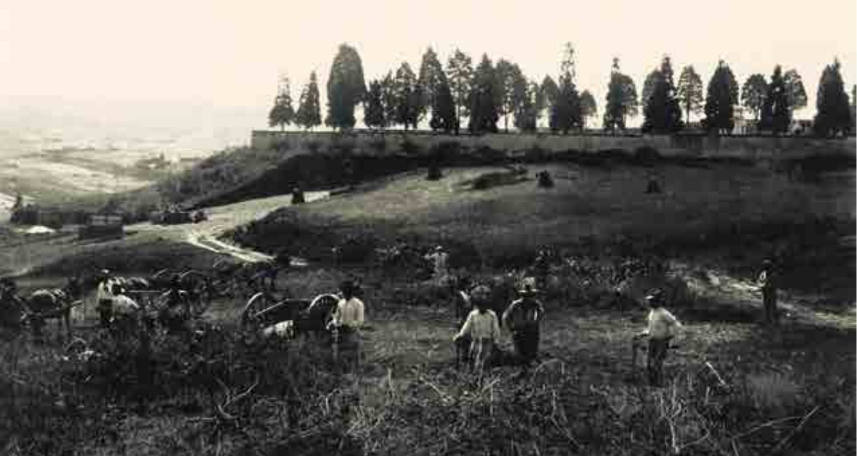
TRABALHADORES REALIZAM A PREPARAÇÃO DO TERRENO PARA A INSTALAÇÃO DO CEMITÉRIO ISRAELITA DE VILA MARIANA, AO LADO DO CEMITÉRIO MUNICIPAL DA VILA MARIANA, DÉCADA DE 1910.
